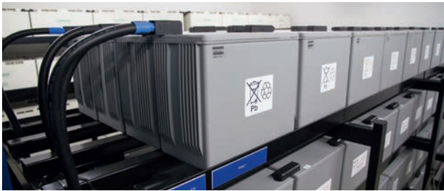
Redundante Energie- und Notstromversorgung (blau)
