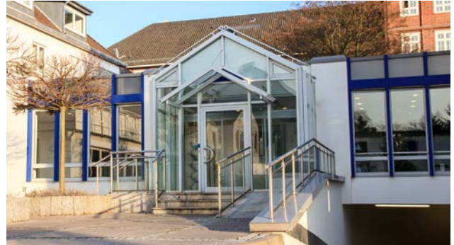
Gebäudezutritt streng geregelt: Zentrale 24x7 Vor-Ort-Kontrollen
